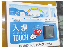
現場に設置されたCCUSカードリーダー
