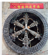
大潭シールド工事貫通式
