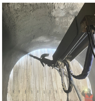
環境配慮型吹付けコンクリート施工状況
