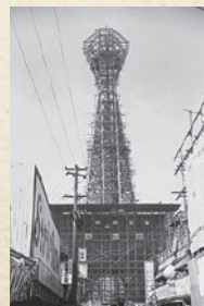
新世界にそびえる 建設中の二代目通天閣
