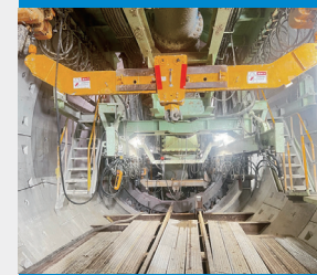
シールドマシン遠隔操作状況②
