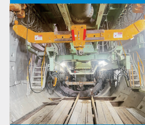
シールドマシン遠隔操作状況②
