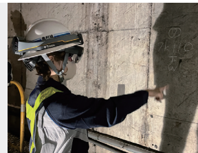
施工影響XRウォッチャーを利用した監視業務の実施状況
