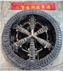
大潭シールド工事貫通式
