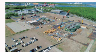
発電所予定地(建設中)
