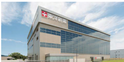
工場:東洋新築 インテリジェンスパーク第一工場(佐賀県鳥栖市)
