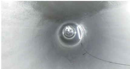
上・下水道:新川第6排水区新川16号幹線(雨水)(その1)公共下水道工事(京都府京都市)
