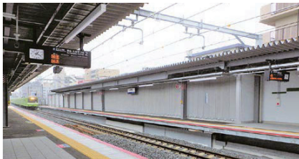
鉄道:おおさか東線野江地区踏盤新設他工事(大阪府大阪市)
