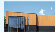
開口部を取り替えてさまざまなファサード(外装)を設置し、意匠性、快適性および省エネ効果を検証できる「室内環境実験室」
