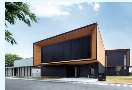
室内環境実験棟
