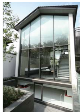
免震装置見学スペース
