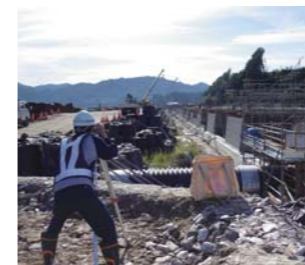
インターンシップの職業体験 (岩手県 山田町織笠漁港工事例)
