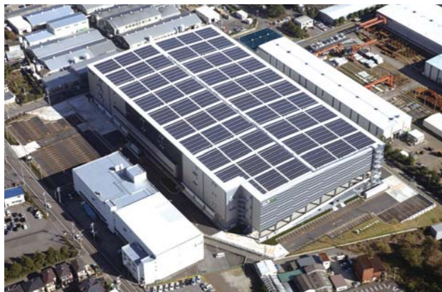
太陽光発電パネルの設置状況(建物屋上)
