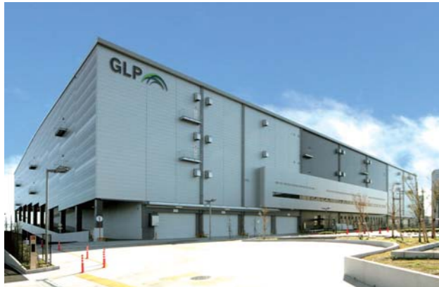
外壁サンドイッチパネルの採用(外観)
