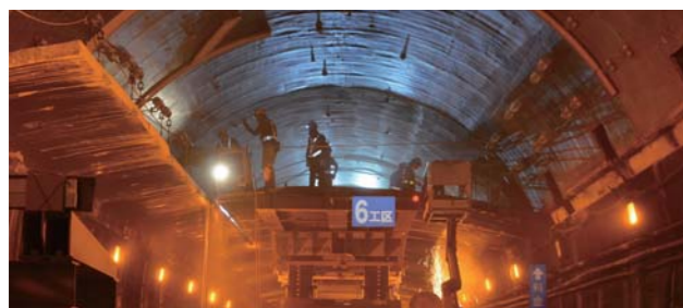
天井板中央部の縦断切断状況
