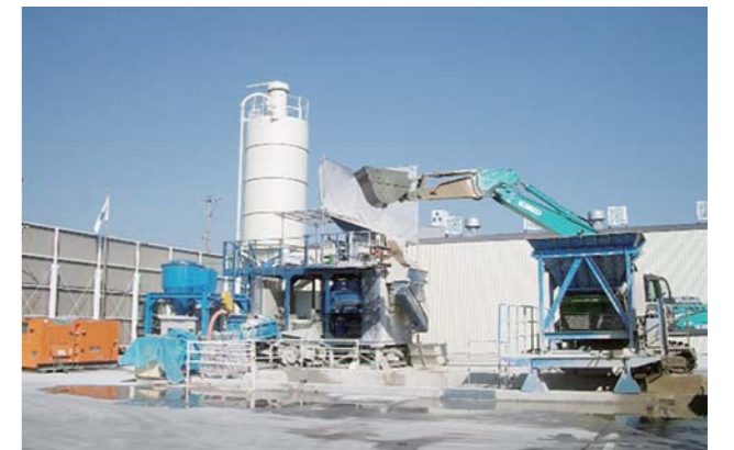
写真2 不溶化処理の状況
