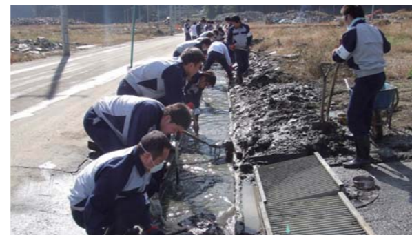
側溝の泥・瓦礫のかき出し
