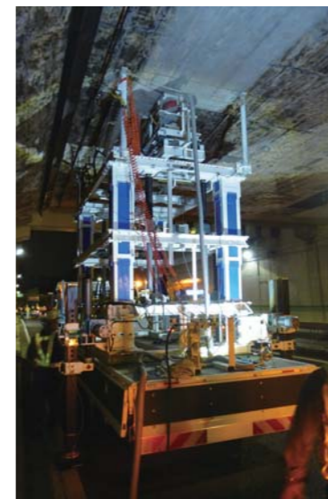
乾式自動研掃装置による施工状況
