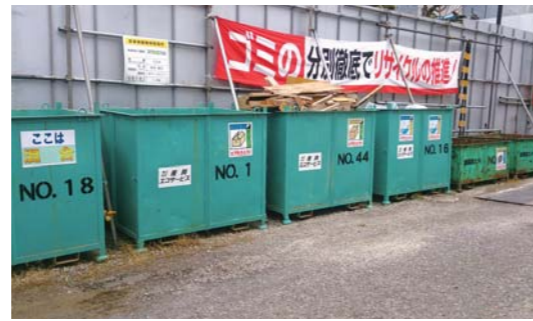
建設現場での分別リサイクル
