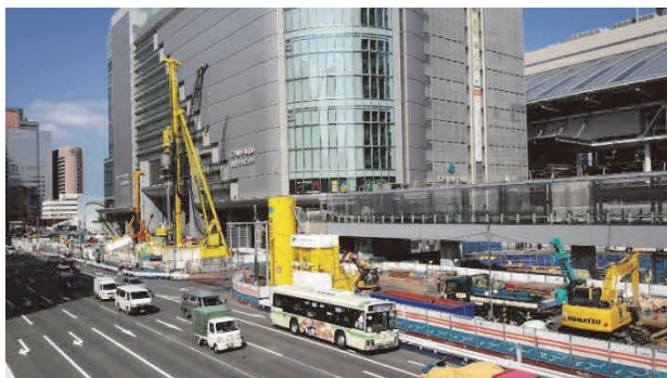
施工中の状況
