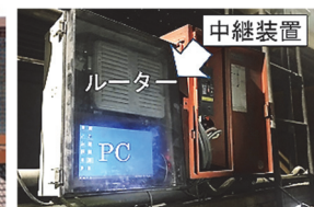
(d) 中継装置の設置状況
