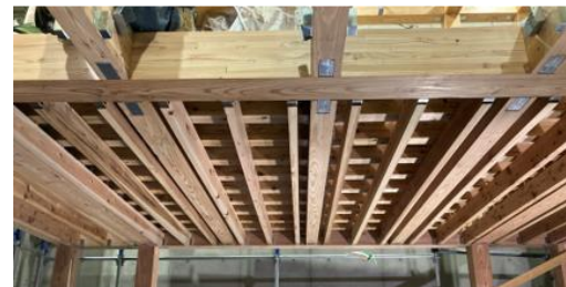
写真－3 天井見上げ
