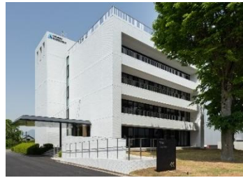
写真－1 建物外観
