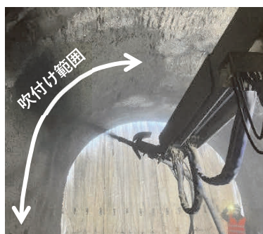
写真-1 吹付け状況
