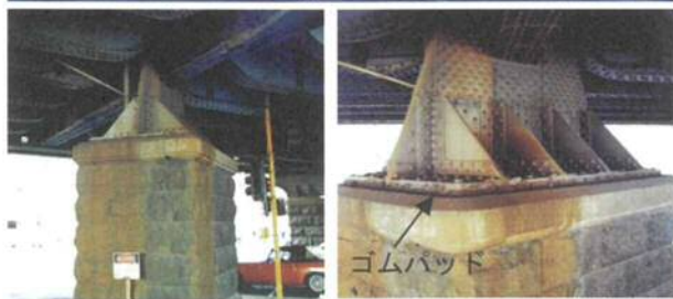
写真 1-1 メルボルンの鉄道橋梁
