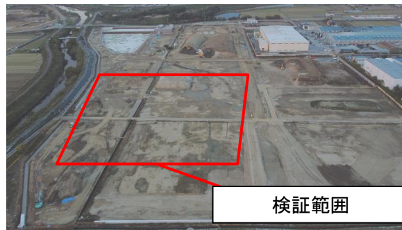
図 35 施工場所全景
