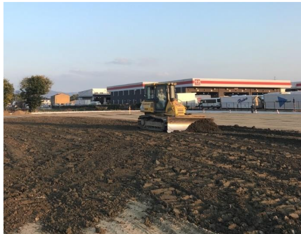
図 36 施工状況（敷均し）
