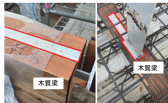
写真-3 鋼板挿入部でのノロ漏れ対策状況
