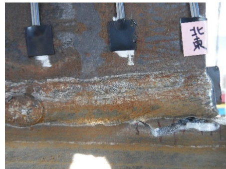
(d)+11 サイクル<耐力 10%減> 北東溶接部
