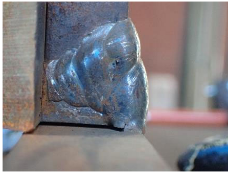
(a)+3 サイクル<亀裂発生> 南東溶接部
