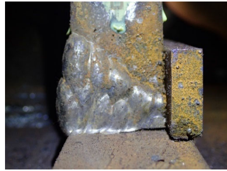
(b)+3 サイクル<亀裂発生> (西ダイアフラム側)
