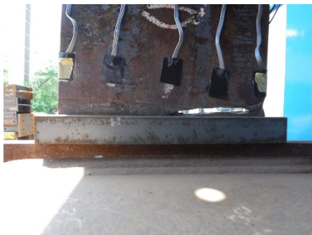
(g)+16 サイクル<破断> 東面溶接部
