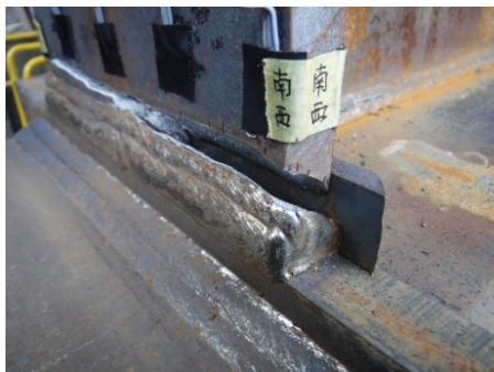
(g)－24 サイクル<破断> 南西溶接部
