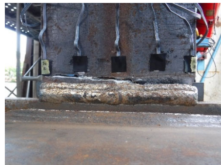
(h)－24 サイクル<破断> 西面溶接部
