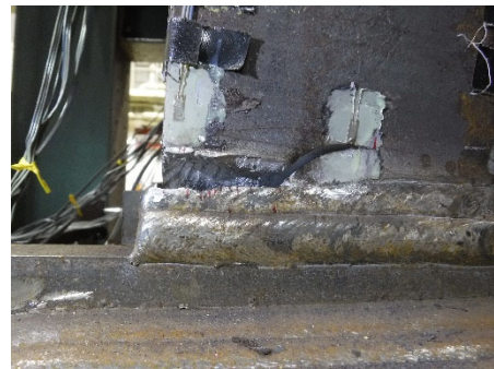
(d)+18 サイクル<破断前のピーク> (東フランジ側)
