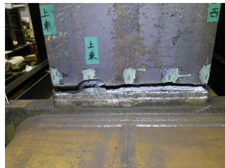
(f)+19 サイクル<破断> (フランジ側)
