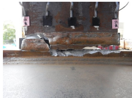
(h)+15 サイクル<破断> 東面溶接部
