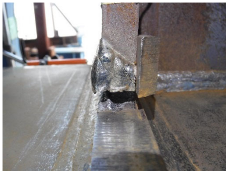
(c)+21 サイクル<耐力 10%減> 北東溶接部
