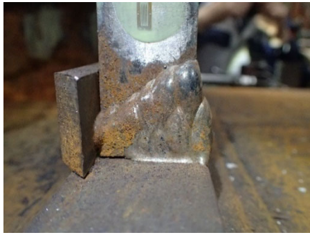
(a)+3 サイクル<亀裂発生> (東フランジ側)
