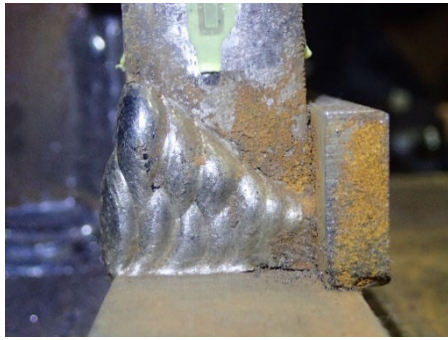
(a)+1 サイクル<浮き発生> (西ダイアフラム側)
