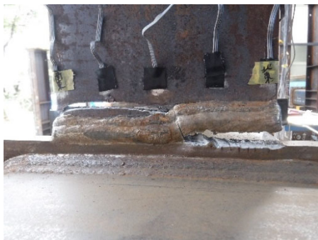
(g)+23 サイクル<破断> 東面溶接部
