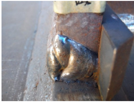
(a)－8 サイクル<亀裂発生> 南西溶接部
