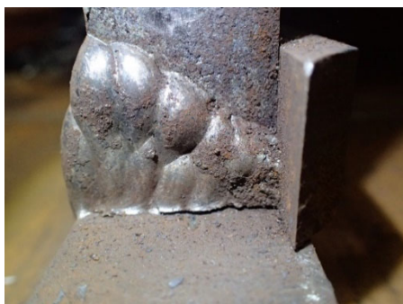
(g)+3 サイクル<亀裂発生> 上フランジ (西ダイアフラム側)
