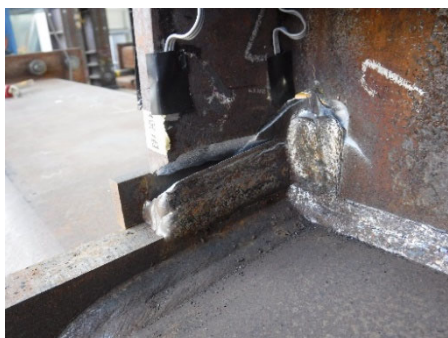
(g)－20 サイクル<破断> 南西溶接部
