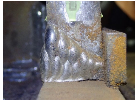
(b)+2 サイクル<亀裂発生> (西ダイアフラム側)
