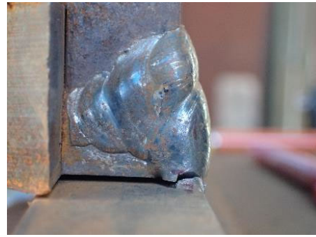
(b)+5 サイクル<板厚貫通> 南東溶接部
