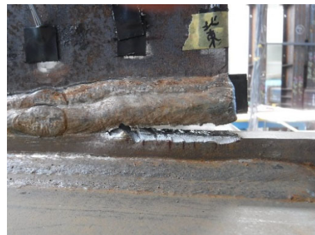
(f)+22 サイクル<幅方向亀裂 78mm> 北東溶接部
