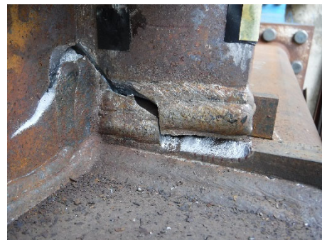
(h)+19 サイクル<破断> 南東溶接部
