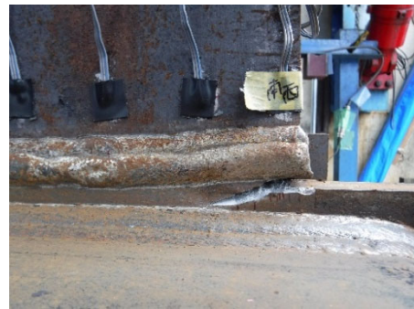
(d)-15 サイクル<耐力 10%減> 南西溶接部
