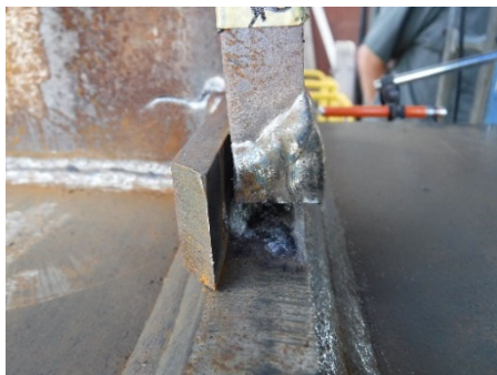
(e)+21 サイクル<破断前のピーク> 南東溶接部
