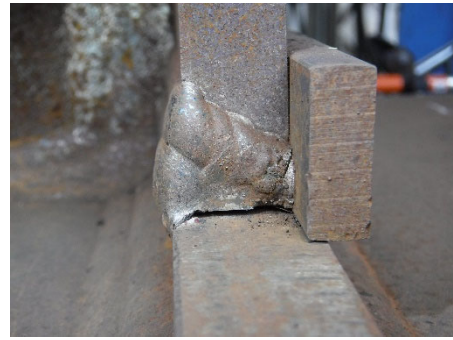
(b)+4 サイクル<板厚貫通> 南東溶接部
