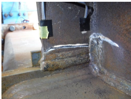
(e)+16 サイクル<破断> 北東溶接部
