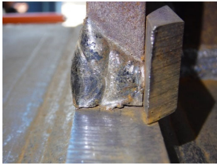
(a)+6 サイクル<亀裂発生> 北東溶接部
