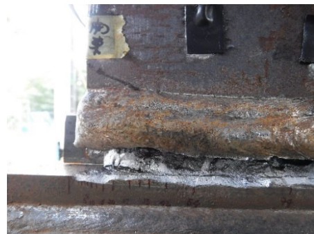
(h)+22 サイクル<破断> 南東溶接部
