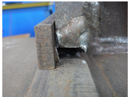
(c)－11 サイクル<耐力 10%減> 南西溶接部
