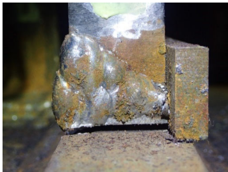
(c)-2 サイクル<幅方向亀裂> (東ダイアフラム側)
