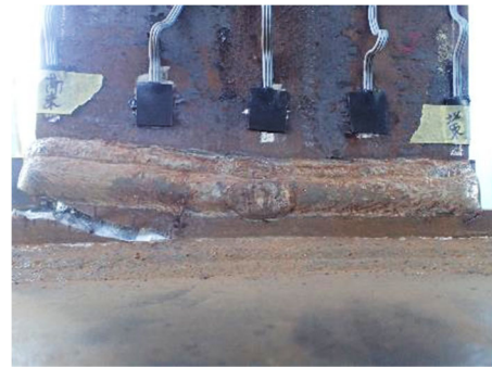
(d)+19 サイクル<耐力 10%減> 東面溶接部
