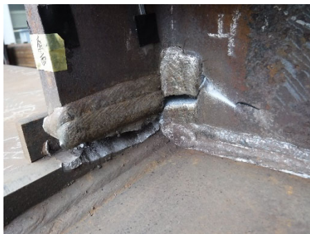
(g)－13 サイクル<破断> 南西溶接部
