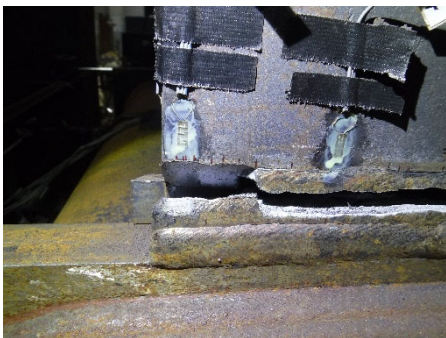
(g)－22 サイクル<破断> (東フランジ側)
