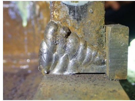
(b)+2 サイクル<亀裂発生> (東ダイアフラム側)
