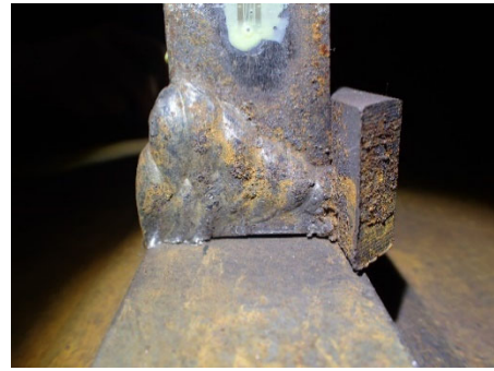
(b)+1 サイクル<浮き発生> (西ダイアフラム側)
