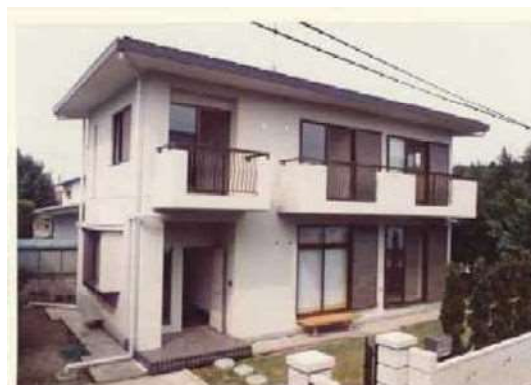
写真 1.1 八千代台免震住宅
