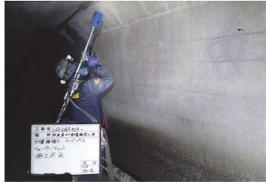
写真-14 WJによる施工上状況
