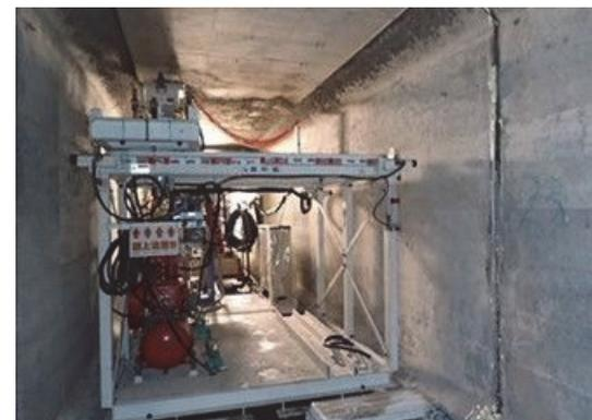
写真-13 小型研掃装置による施工状況
