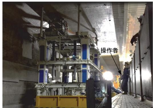
写真-7 研掃装置による施工状況
