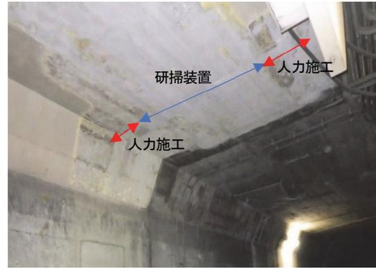
写真-10 研掃による仕上がり面の状況
