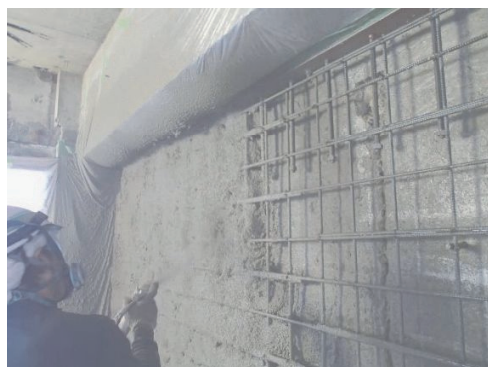
写真-8 吹付け施工状況
