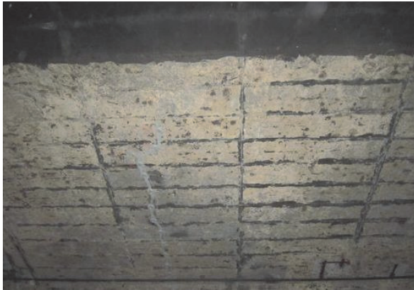
写真-12 処理面出来形の比較（左：人力による施工 右：研掃装置による施工）
