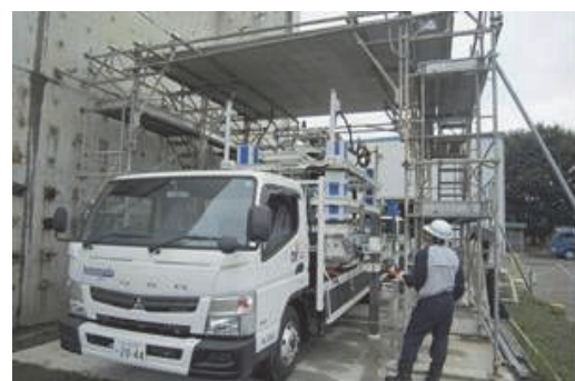
写真-9 全体試験状況
