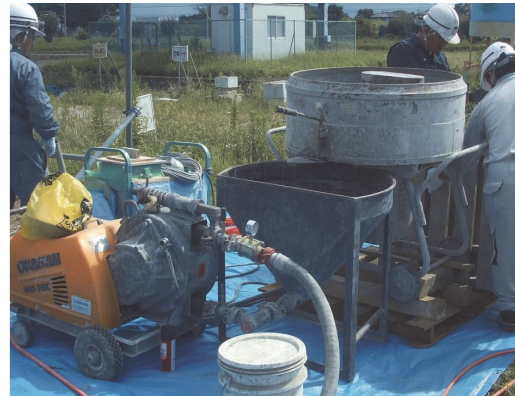
写真-1 PCM練り混ぜ状況
