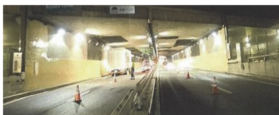
写真-10 適用トンネル外観
