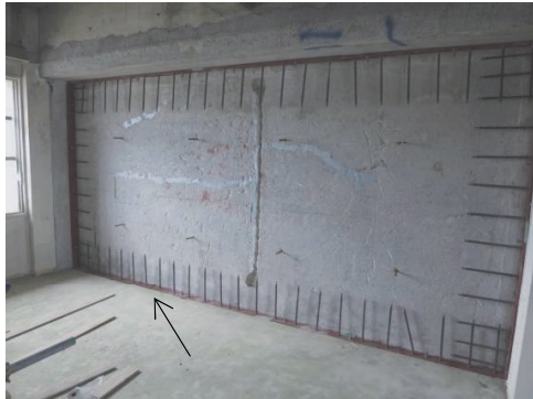
写真-6 接合筋付き鋼板の取付け完了状況
