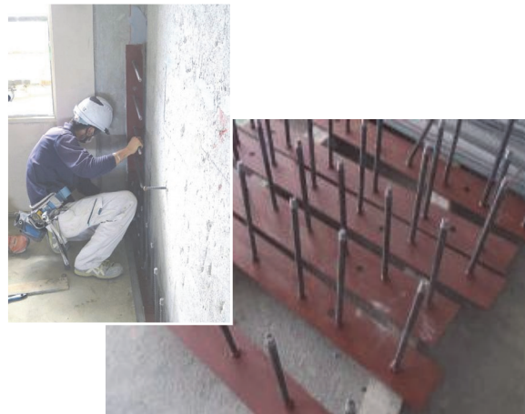
<接合筋付き鋼板>
