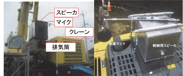
左:ラフテレーンクレーン、右:バックホウ
