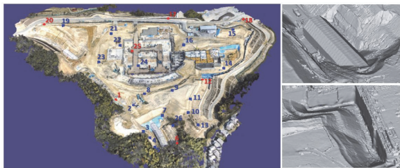
図-23 UAV計測による3次元モデル
