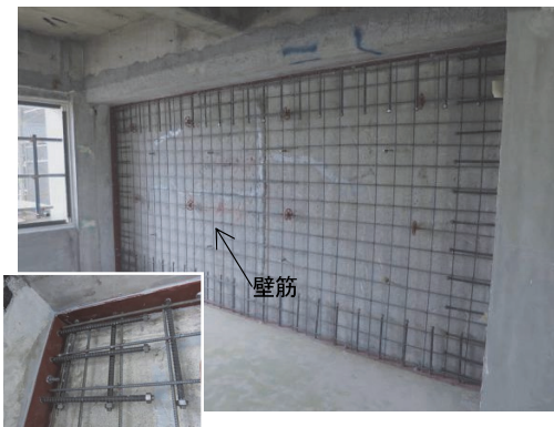
写真-7 配筋状況
