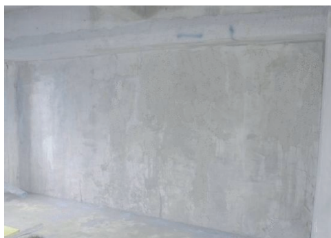
写真-9 仕上げ状況
