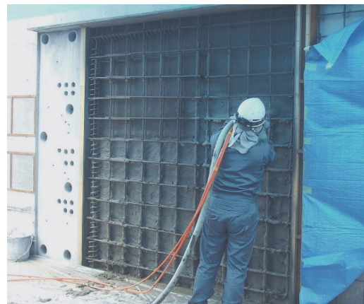
写真-2 吹付け施工状況
