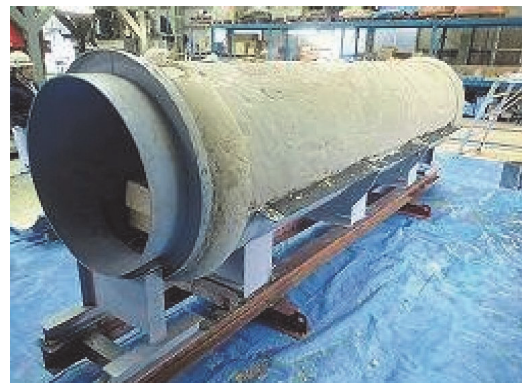
写真-5 硬化後の充填状況（ケース 2）
