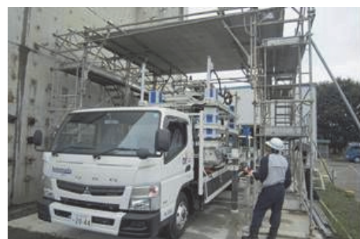
写真-9 全体試験状況
