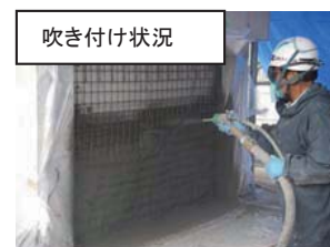
写真-1 施工状況
