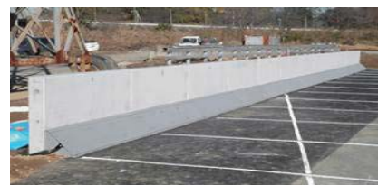
写真－1 プレキャスト高欄設置状況
