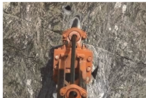
写真-2 穿孔時のロッドの状況
