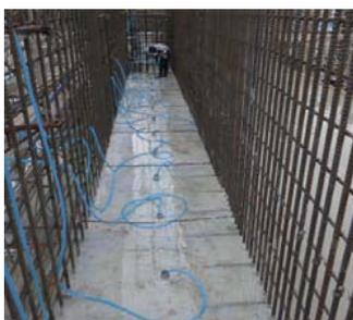
写真-1 鉛直パイプクーリング状況
