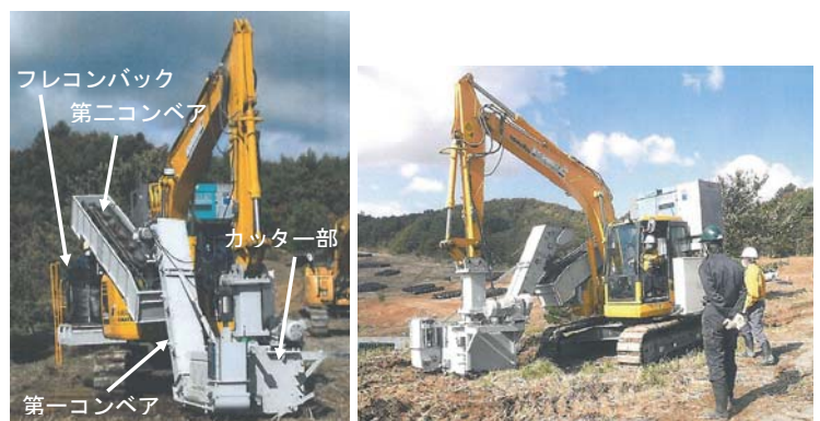
写真-1 ロータリーカッター機の施工状況
