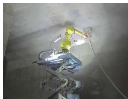
写真-2 天井用WJ表面処理機の施工状況（研掃）
