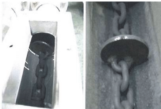
写真-3 第一コンベア (パイプコンベア)
