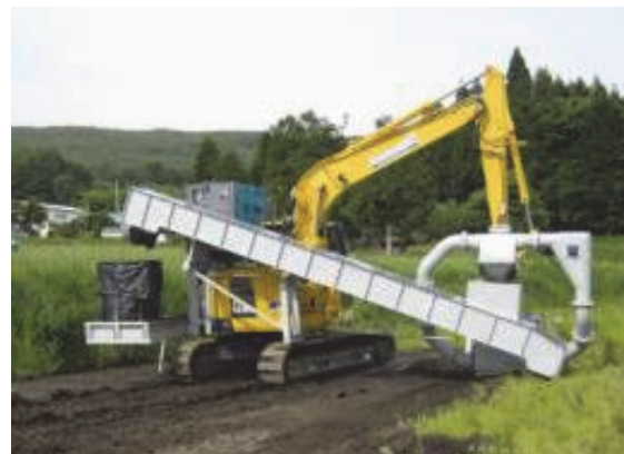
写真-5 ロータリーカッター1号機による実証試験状況
