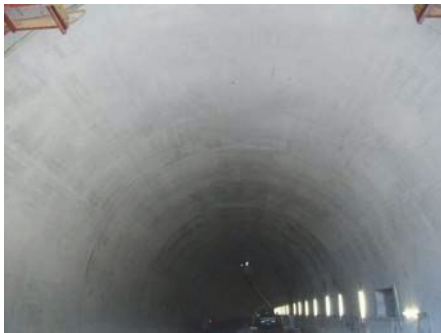
写真-7 覆工表面の仕上がり
