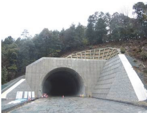
写真-1 田上トンネル抗口
