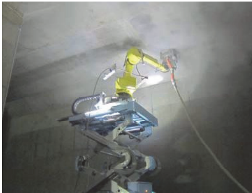
写真-6 施工状況 (研掃)
