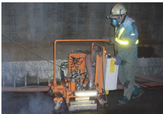
写真-9 施工状況（塗膜除去）
