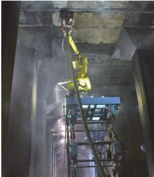
写真-7 施工状況（塗膜除去）
