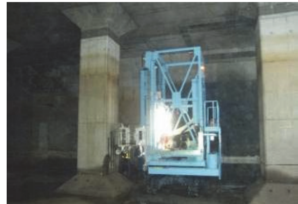
写真-10 壁・柱用WJ表面処理機の施工状況
