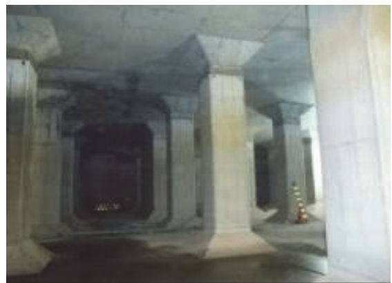
写真-5 上水道給水所の配水池
