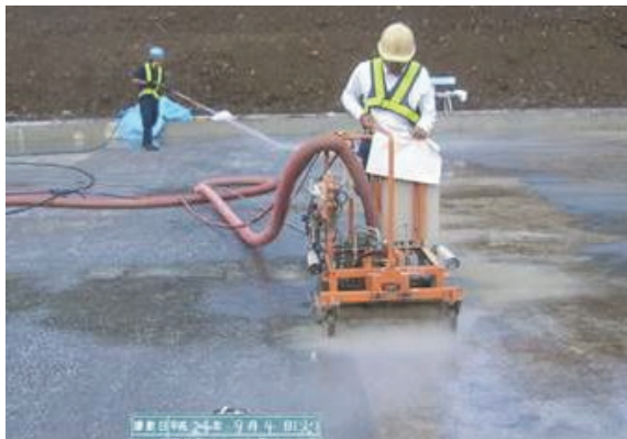
写真-8 施工状況（研掃）
