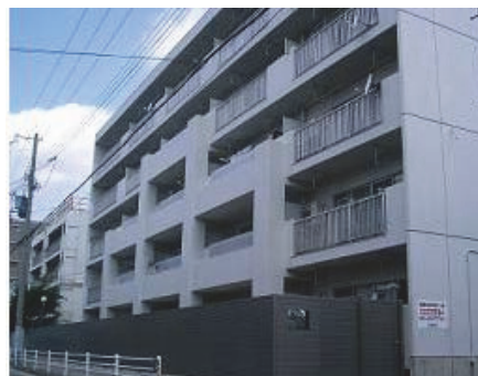
写真-15 工事完了後の建物外観
