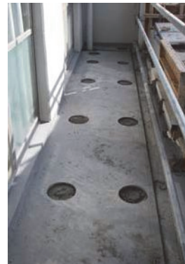
写真-14 鋼管の挿入作業完了直後
