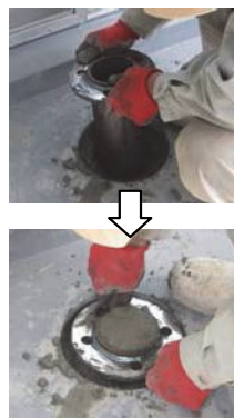
写真-13 鋼管の挿入作業状況
