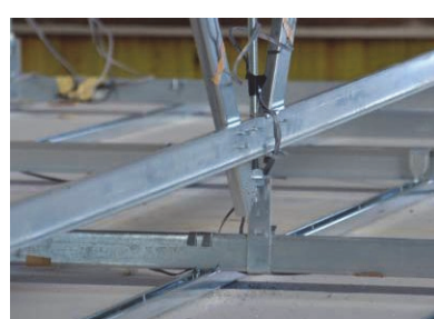
写真-7 ブレース下部 (繫材) (野縁方向: 従来)
