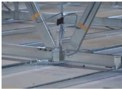
写真-6 ブレース下部 (野縁受け方向: 共通)
