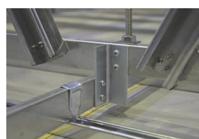
写真-8 ブレース下部 (繫材) (野縁方向: 改良)
