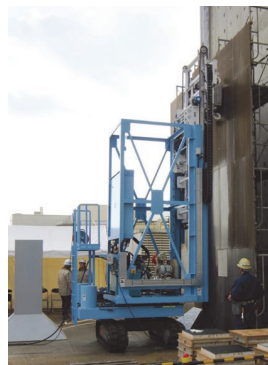
写真-2 施工性能試験状況
