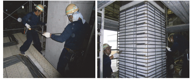
写真-1 普通鉄筋の組立状況
