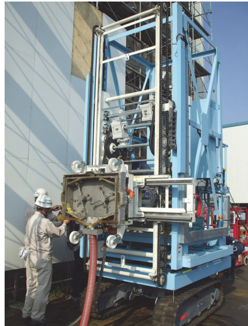
写真-4 飛散抑止性能試験状況
