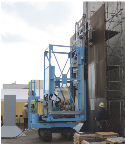
写真-2 施工性能試験状況
