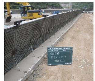
写真-14 残存型枠の設置
