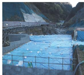
写真-13 打設面の養生
