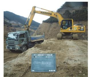
写真-8 CSG材の積込み
