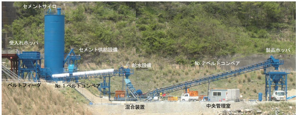
写真-6 CSG混合設備の全景
