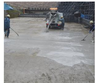
写真-10 打継面処理
