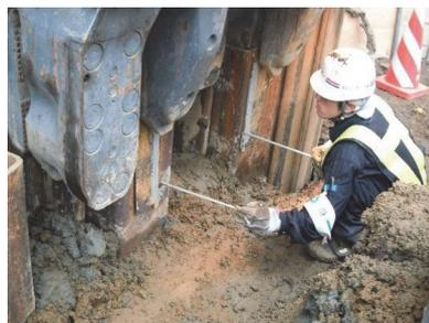
写真-5 角度補正プレートのセット
