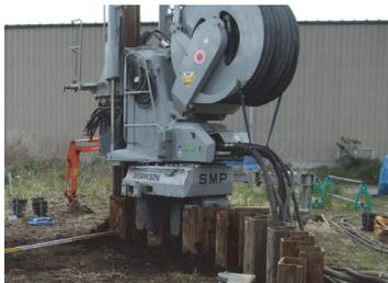
写真-1 鋼矢板の円形打設
