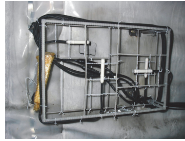
写真-1 計測機器の設置状況
