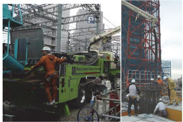
写真-3 ポンプ車による打設状況
