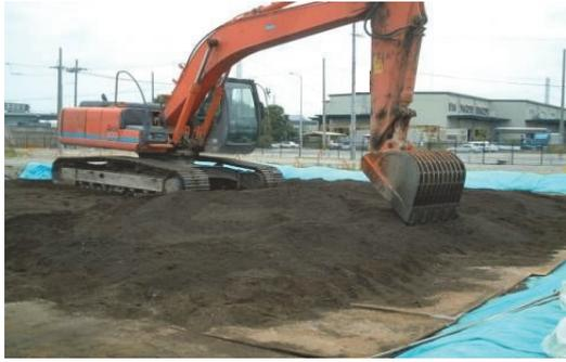
写真-8 想定施工状況（ラッド・ファームing 工法）
