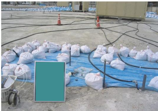
写真-9 想定施工状況（注入工法）
