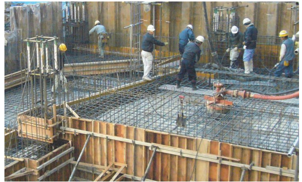
写真-5 基礎コンクリート打設状況
