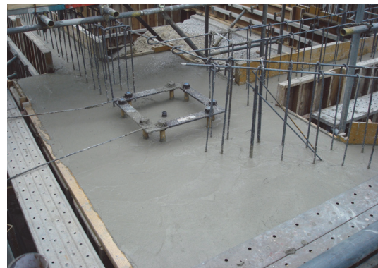
写真-6 地中梁・フーチング打ち上がり状況
