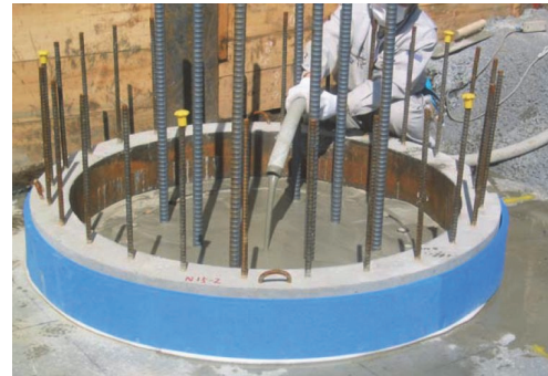
写真-2 杭頭接合部の施工状況
