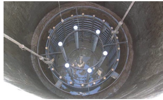
写真-1 杭鉄筋の建て込み状況
