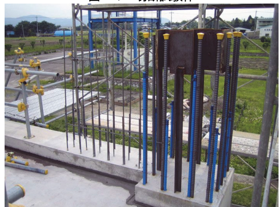
写真-1 切断試験体の配筋・鉄骨設置状況
