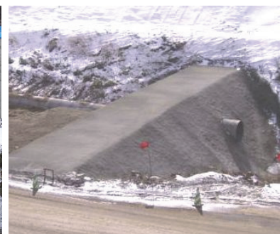
写真-5 施工完了状況
