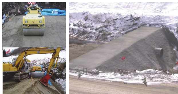
写真-4 転圧状況
