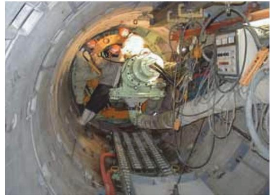
写真-7 スクリュコンベヤの機内設備状況
