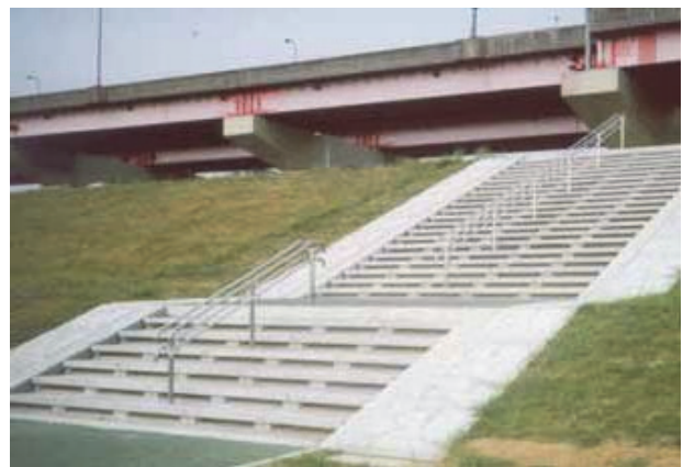
写真-3 階段ブロック適用例
