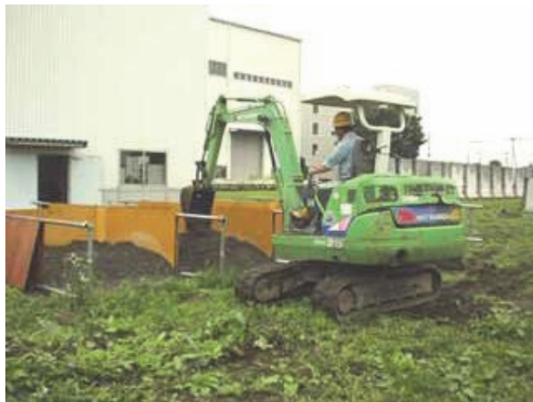
写真-1 小規模実証実験の攪拌状況
