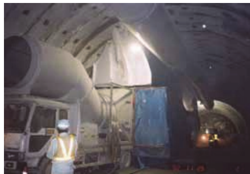
写真-3 遮風シートの設置状況
