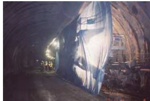
写真-2 分離幕の設置状況
