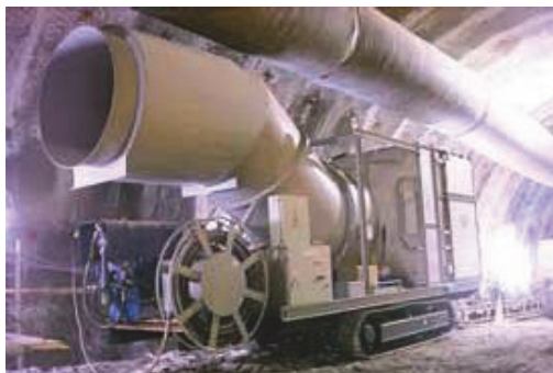
写真-1 クローラ型電気集じん機
