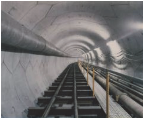
写真-1 ハニカムセグメント出来形状況
