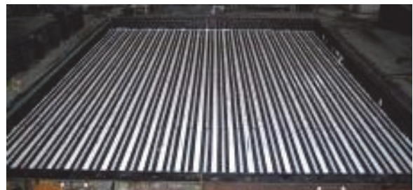
写真-3 フェライトタイルユニット敷設状況
