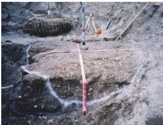
写真-1 改良体の試掘(ケース3)
