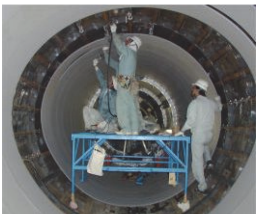
写真-3 支保工の設置状況
