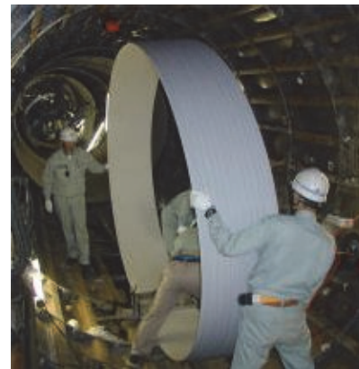
写真-1 ライニング材の熱融着(リング成形)
