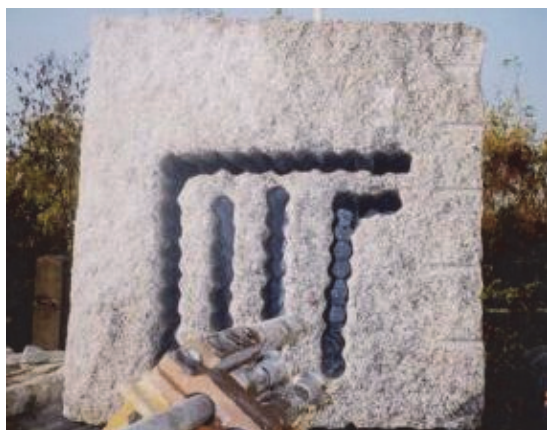
写真-1 工場内における2連孔スロット削孔実験
